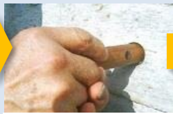
充填棒 (穴あり) 押込 2~3回、回転させる
