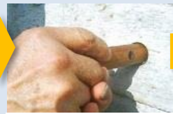
充填棒 (穴あり) 押込 2~3回、回転させる
