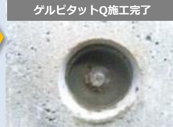
ゲルピタットQ施工完了
