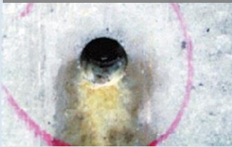
Pコン漏水部分施工前
