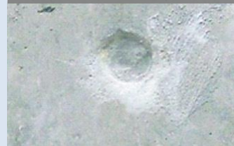
Pコン漏水部分施工後
