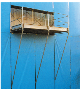
ハンガーステージ吊り材・揺れ止めカブラー設置図
