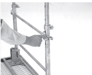
高さ調節はバーロックが決めて 簡単にしかも確実に固定します
