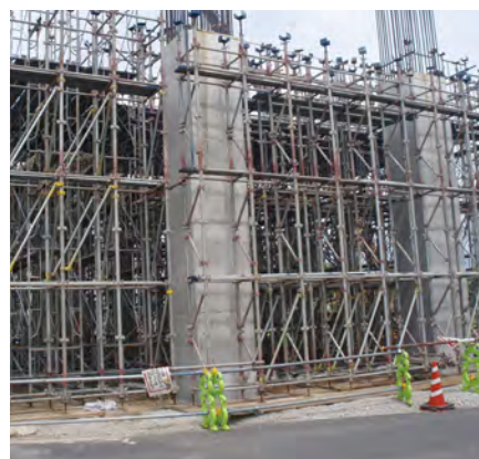
支保工足場材
