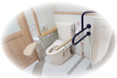
手すり付きで安心の広々トイレ
