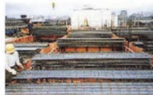
鋼製デッキ型枠
