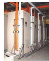
機械室設置 貯湯タンク
