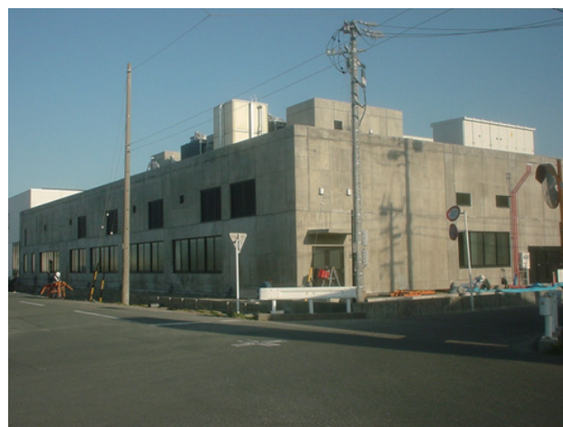
エンジン実験室研究棟（三信工業） 1990
