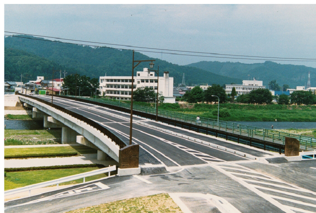
橋梁整備北山橋（南条大橋）
