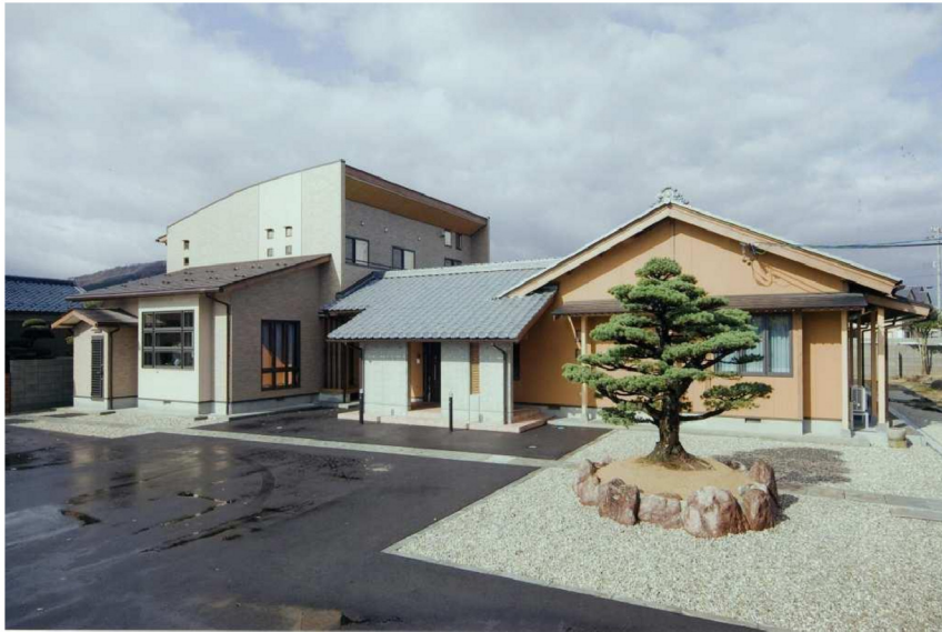
A邸 新築工事
