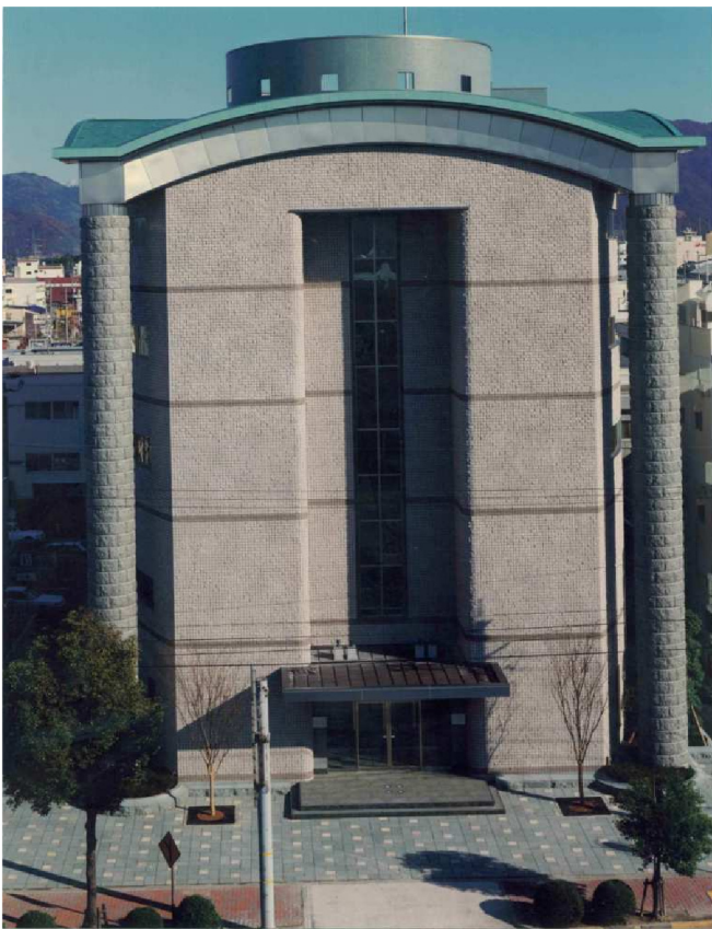
福井銀行福井中央支店新築工事
