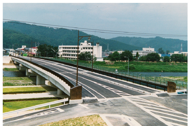
橋梁整備北山山橋（南条大橋）
