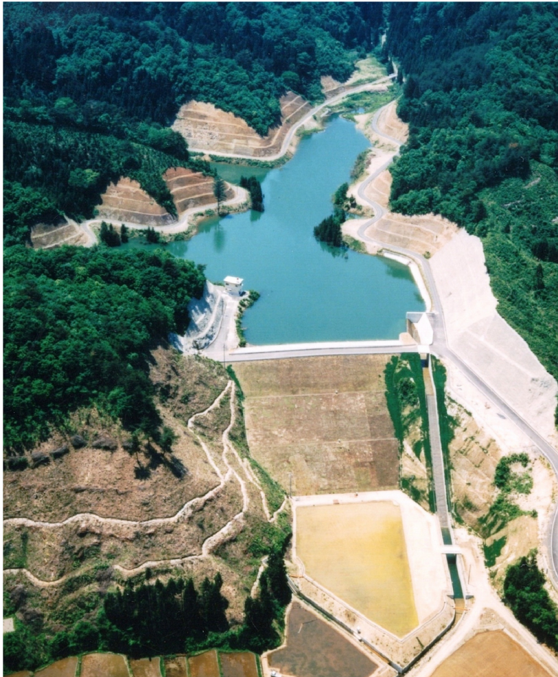
総ヶ谷ダム工事
