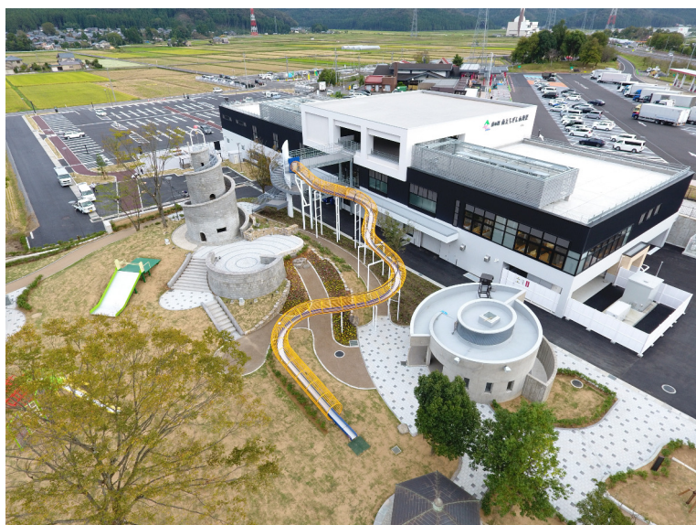
南条SA周辺地域振興施設新築工事（道の駅 南えちぜん山海里） 南条SA周辺地域振興施設公園改修工事・駐車場等整備工事
