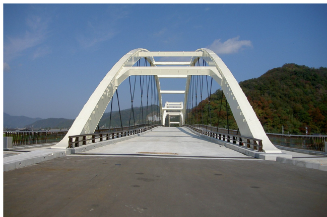
水鳥大橋建設工事
