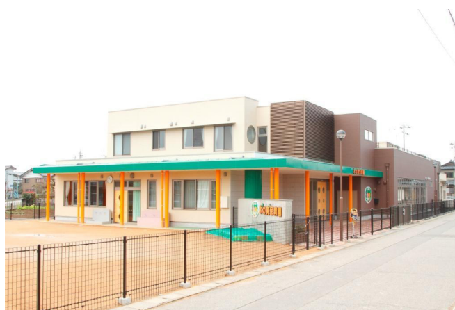
木の実保育園新築工事
