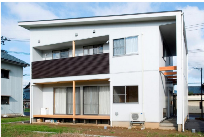
J邸 新築工事
