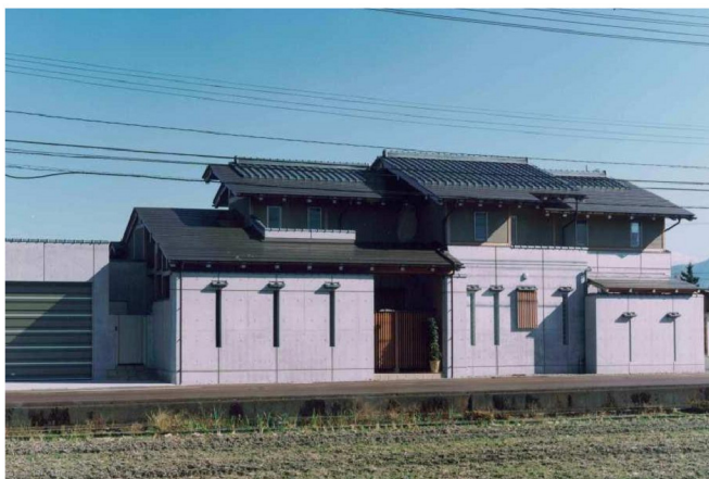
D邸 新築工事
