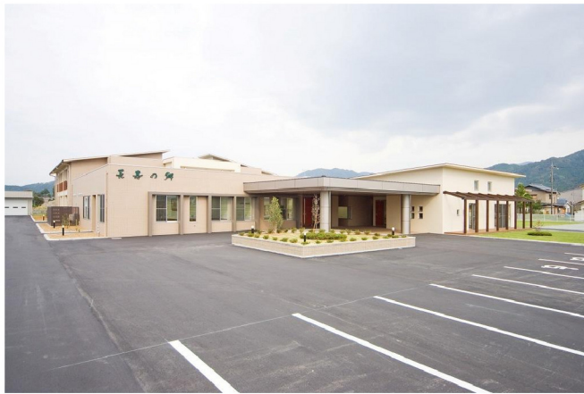
長寿の郷新築工事
