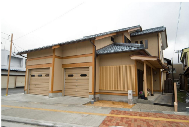
B邸 新築工事
