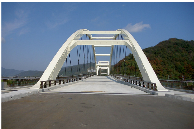
水鳥大橋建設工事
