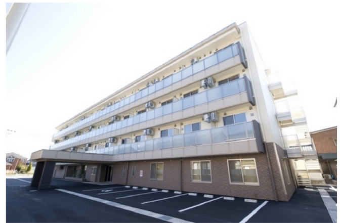
高齢者専用賃貸住宅江守きらめき 新築工事
