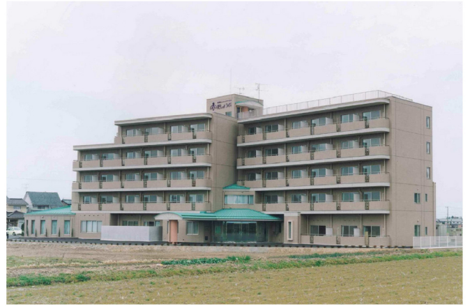
花しょうぶ（ケアハウス）新築工事
