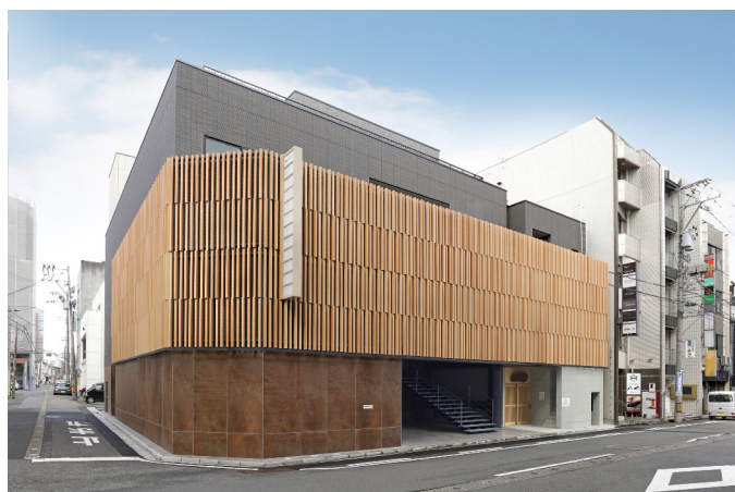
KTビル・さのや新築工事（外観）
