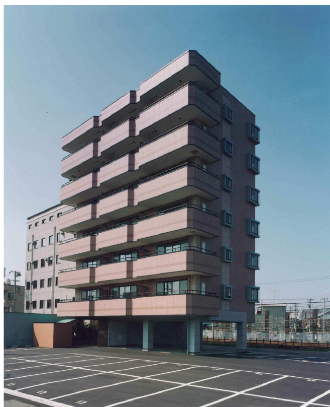
Hマンション新築工事
