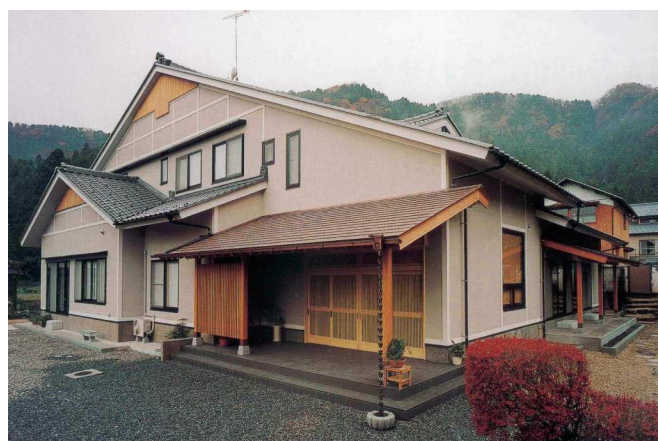
H邸 新築工事
