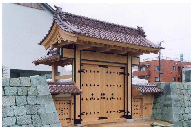
舎人門 復元工事
