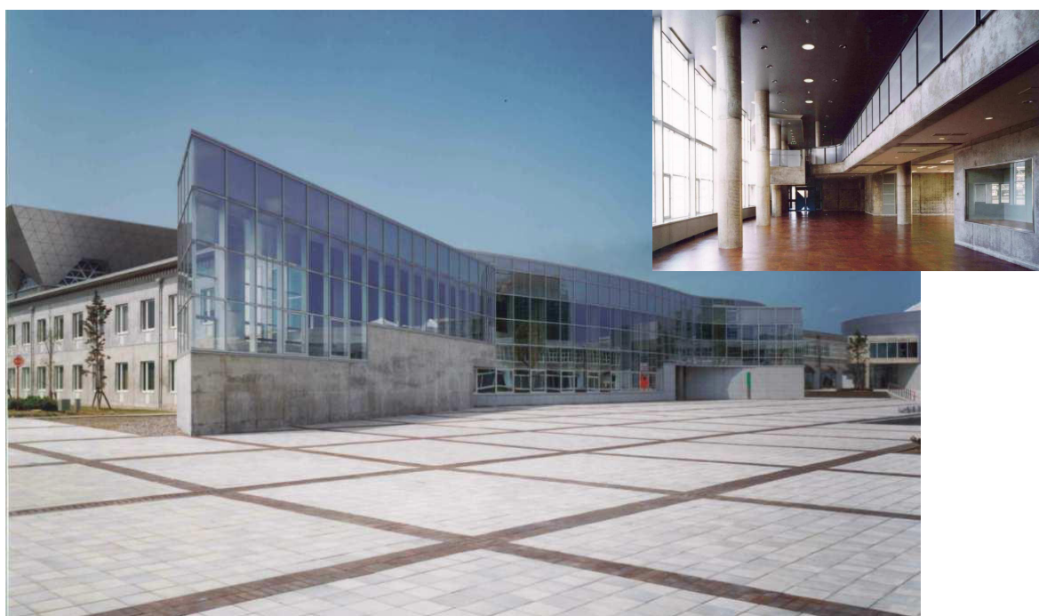
福井県立大学学生会館建築工事
