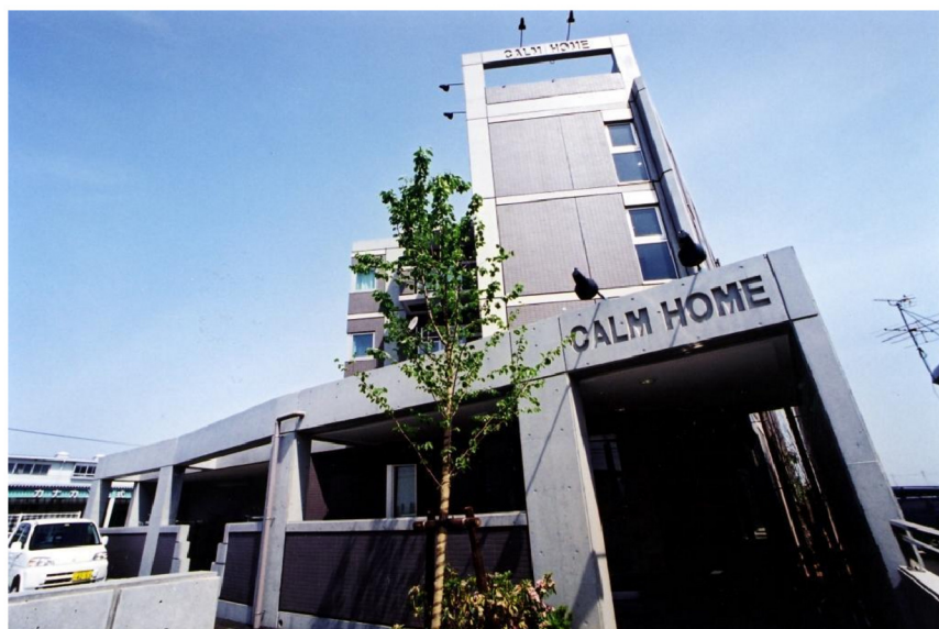
カームホーム（CALM HOME） 新築工事
