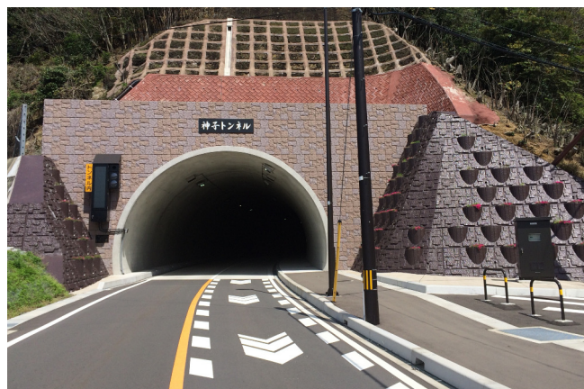
神子トンネル工事 小川工区
