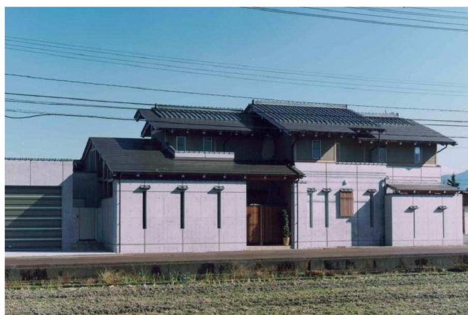
D邸 新築工事
