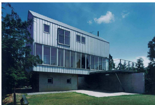
C邸 新築工事
