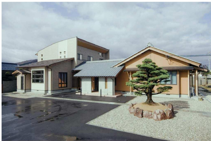
A邸 新築工事
