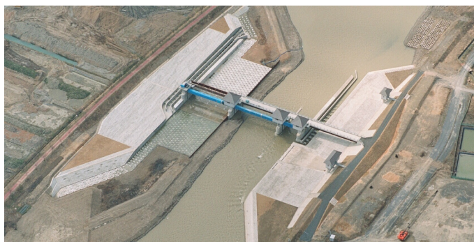
八乙女頭首工建設工事
