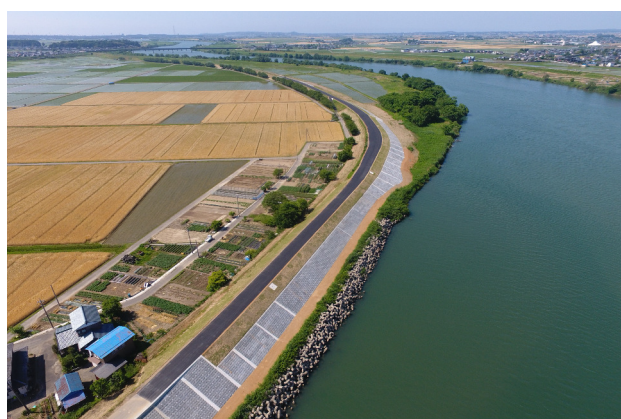
大安寺地区堤防拡幅工事 九頭竜川
