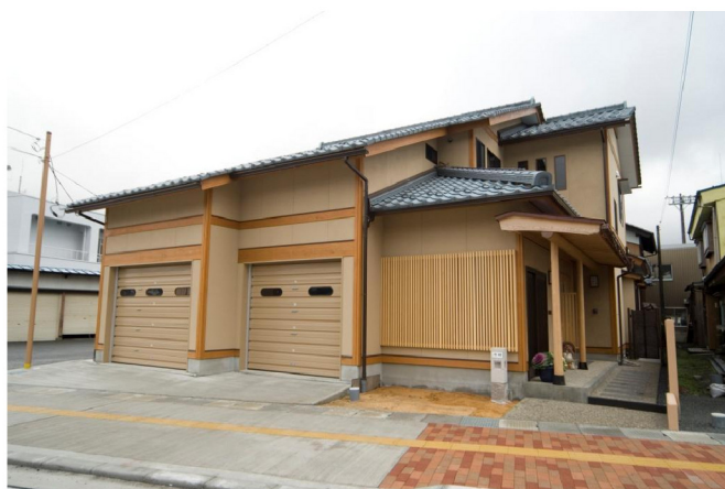
B邸 新築工事
