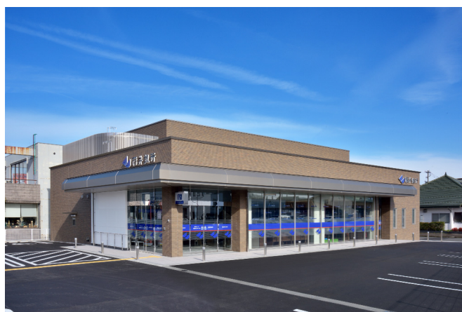
福井銀行種池支店新築工事
