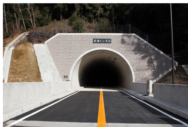
内浦トンネル工事 音海工区
