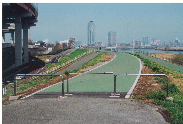
岩淵地区管内坂路整備工事 隅田川
