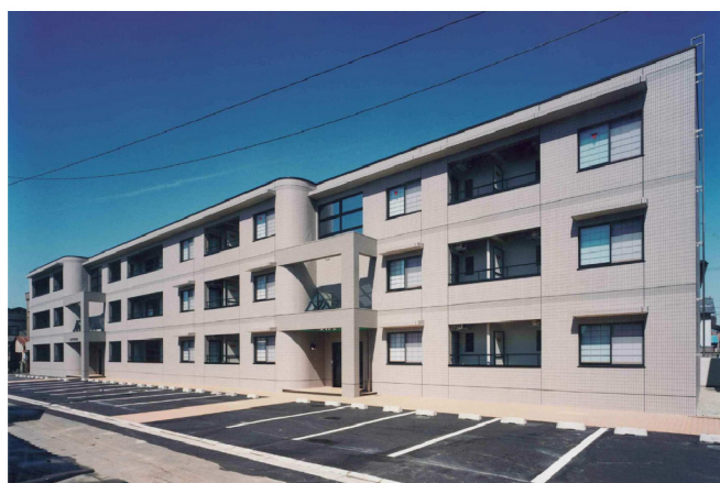
福井銀行宝永社宅 新築工事
