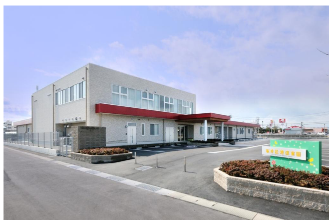
坂井松涛保育園新築工事
