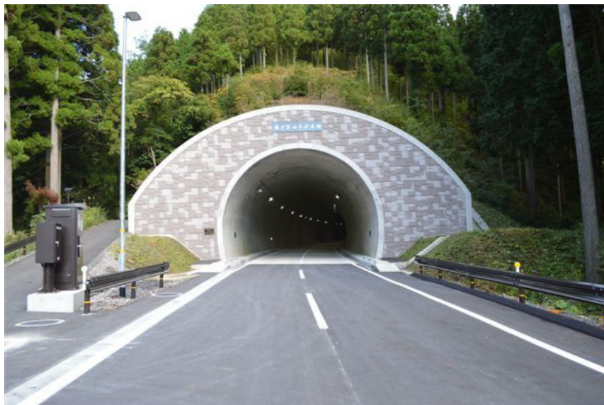
ホノケ山トンネル工事 河野工区
