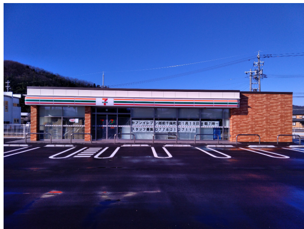
セブンイレブン越前千福町店新築工事
