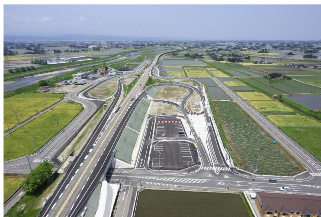
東海北陸自動車道 南砺スマートIC工事
