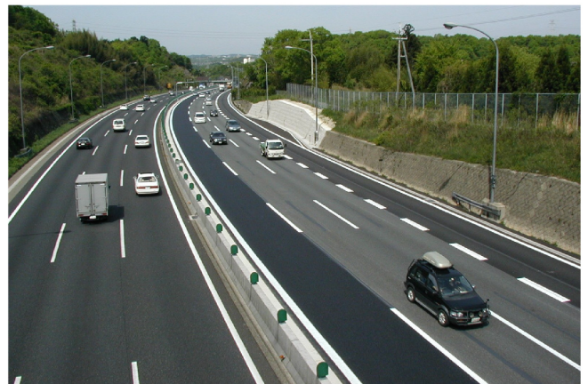
中国自動車道 山口地区登板車線設置工事
