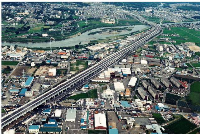
京滋バイパス 宇治西インターチェンジ工事
