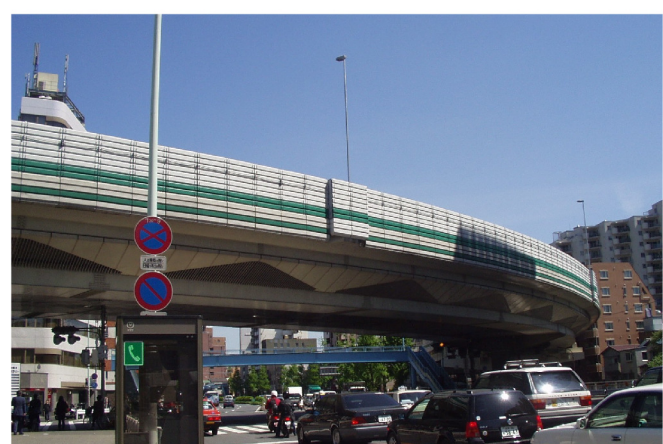
首都高速道路 遮音壁落下防止工事
