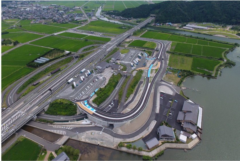
若狭舞鶴自動車道 三方スマートIC工事
