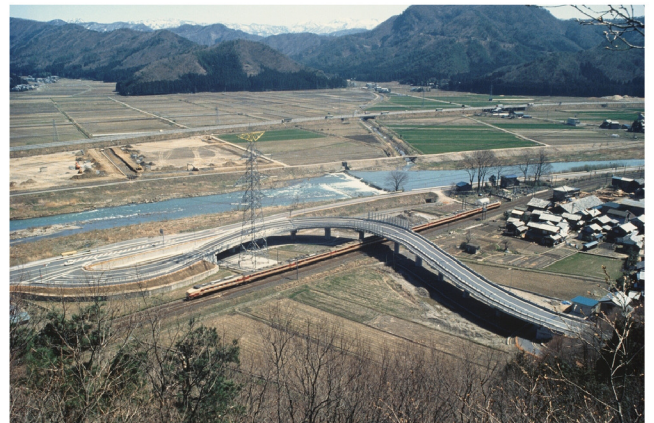
踏切除却事業
