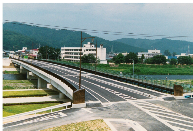
橋梁整備北杣山橋（南条大橋）
