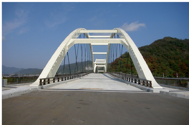
水鳥大橋建設工事
