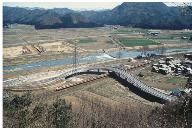
踏切除却事業
