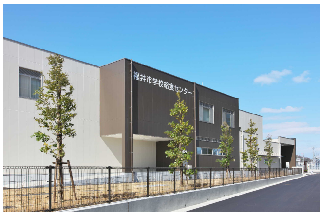
福井市学校給食センター新築工事
