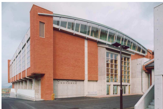
南条小学校屋内運動場他建設工事
