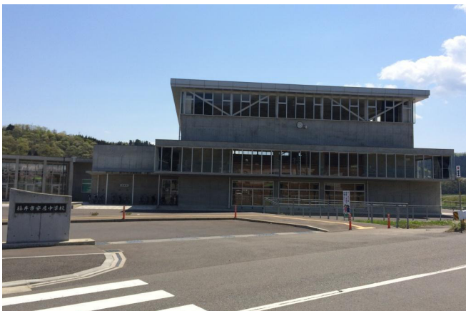
安居中学校校舎新築工事
