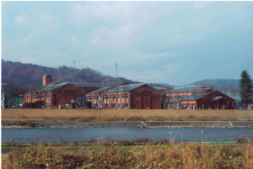
南条小学校校舎新築工事
