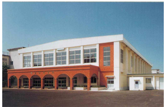
明道中学校体育館改築工事
