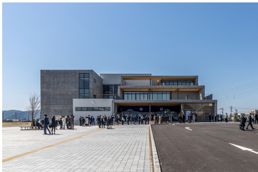
九頭竜中学校新築工事（外観）
