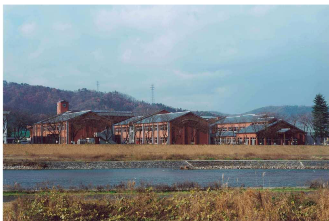
南条小学校校舎新築工事
