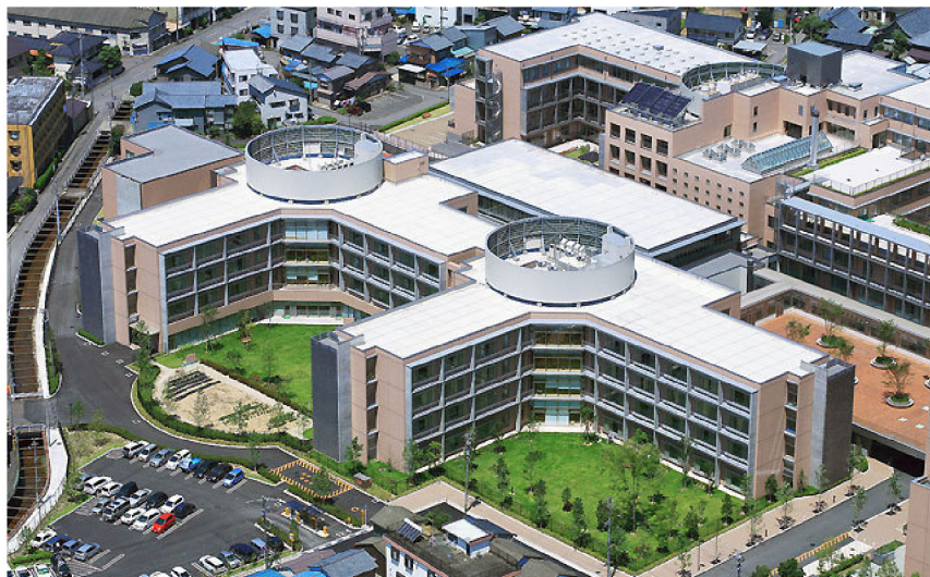
福井県立病院整備事業第二期建設工事(全体)
