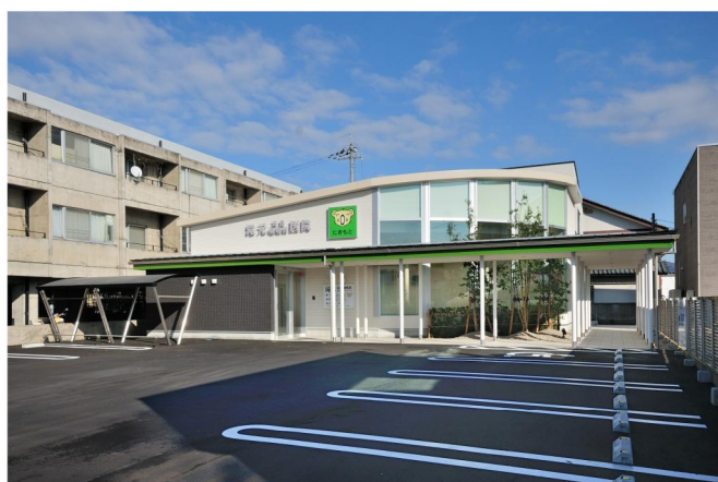
滝元耳鼻咽喉科医院新築工事
