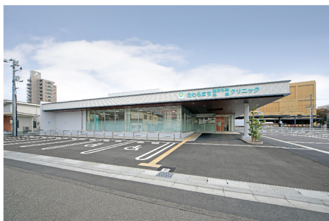
たわらまち整形外科・内科クリニック新築工事
