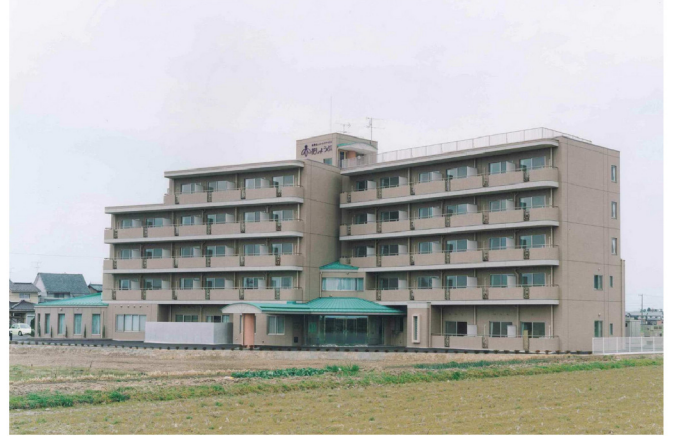
花しょうぶ（ケアハウス）新築工事
