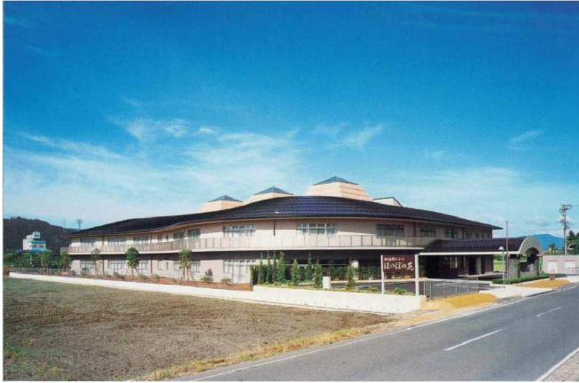
南条郡特別養護老人ホーム整備工事
