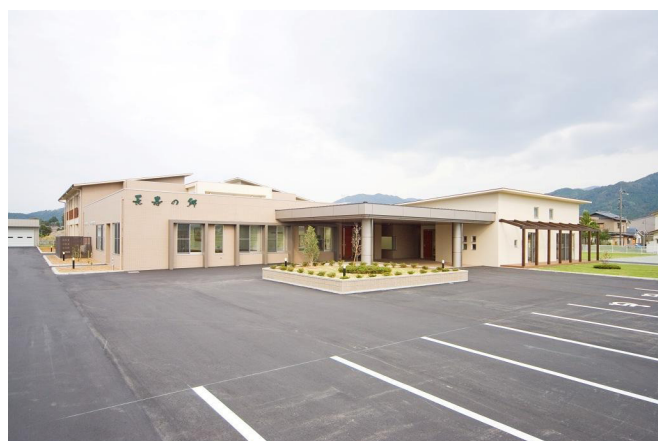
長寿の郷新築工事
