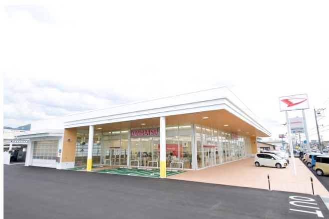
福井ダイハツ新浅水店新築工事
