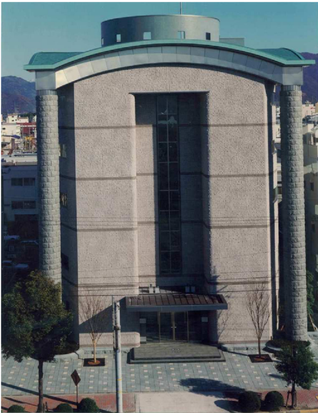
福井銀行福井中央支店新築工事
