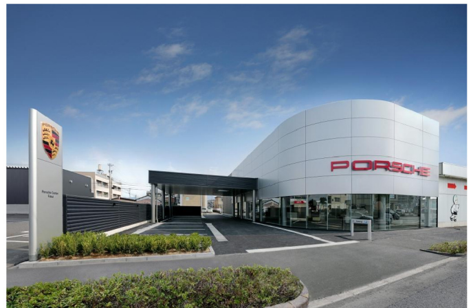
ポルシェセンター福井新築工事
