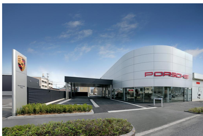
ポルシェセンター福井新築工事
