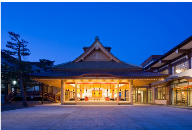
神明神社 神楽殿新築工事
