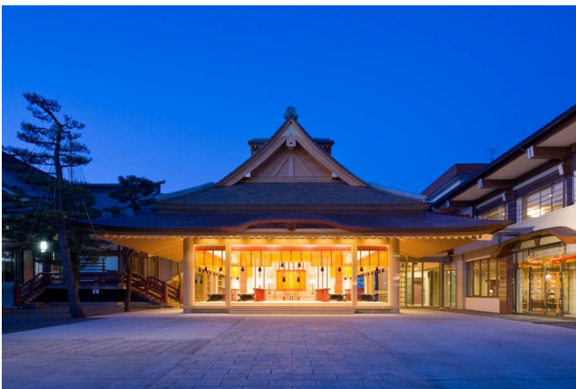
神明神社 神楽殿新築工事
