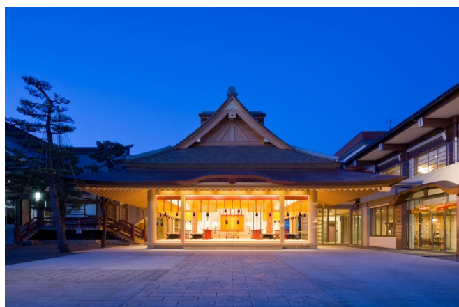
神明神社 神楽殿新築工事
