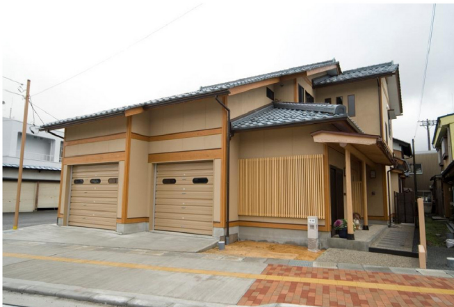
B邸 新築工事
