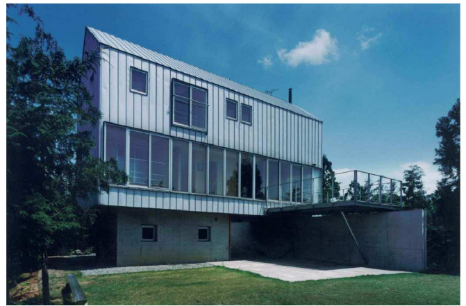
C邸 新築工事
