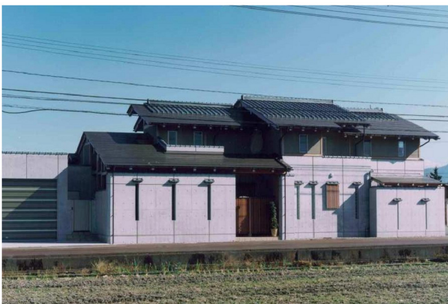
D邸 新築工事
