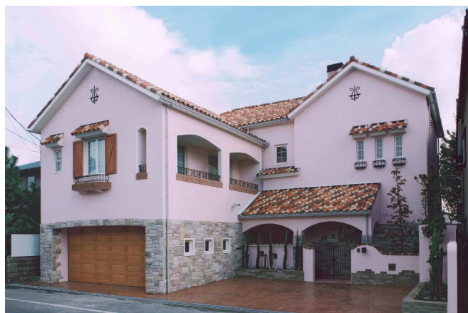
G邸 新築工事
