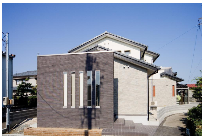
I邸 新築工事
