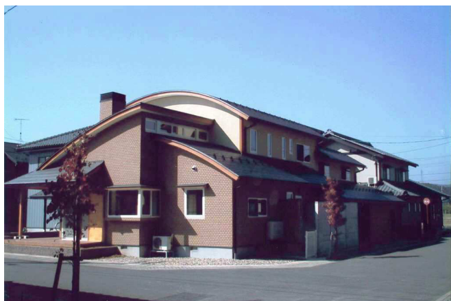
F邸 新築工事
