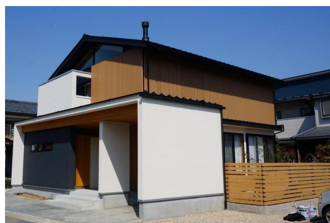
K邸 新築工事
