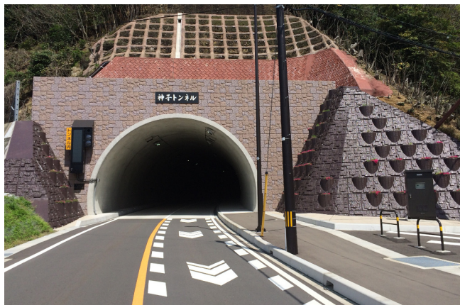
神子トンネル工事 小川工区
