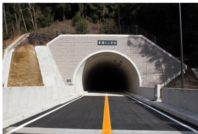
内浦トンネル工事 音海工区
