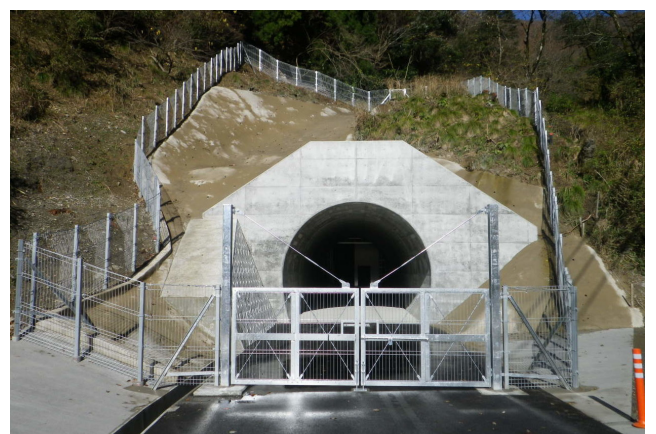
葉原トンネル工事
