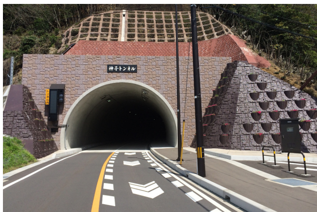
神子トンネル工事 小川工区
