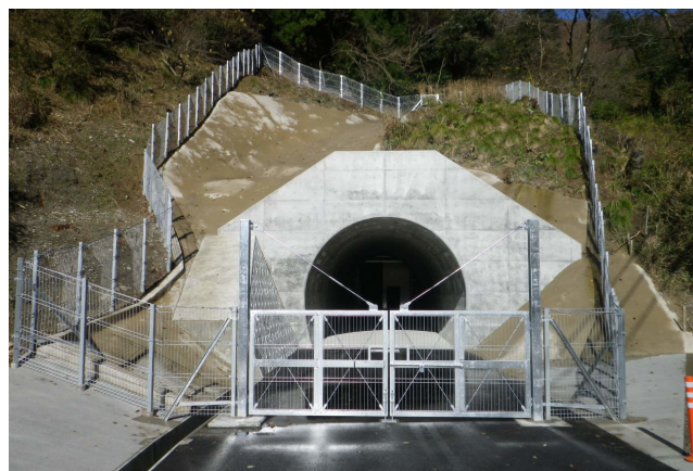
葉原トンネル工事
