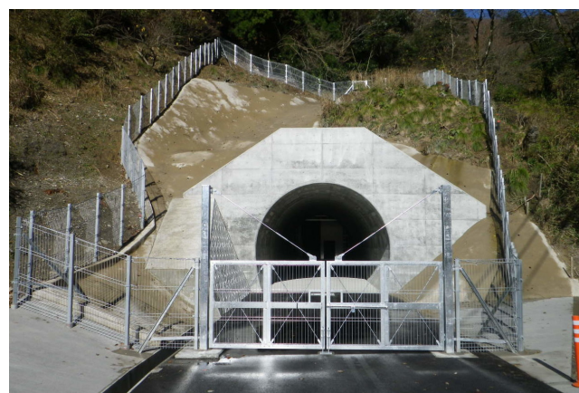
葉原トンネル工事
