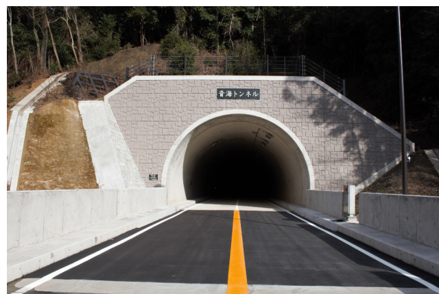
内浦トンネル工事 音海工区
