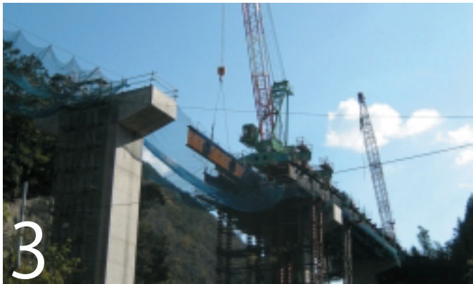
3 トラベラークレーン張り出し架設
