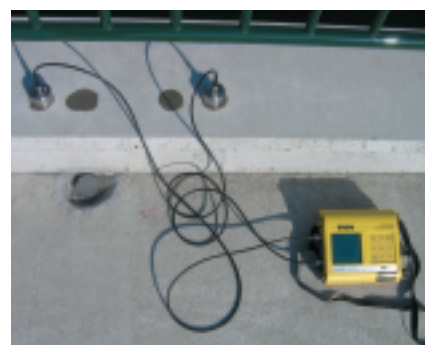
ひび割れ測定
