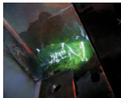
疲労亀裂調査 (磁粉探傷)
