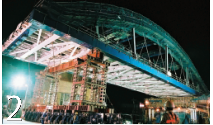
2 大型自走キャリヤ送り出し架設
