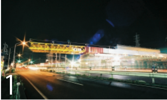
1 手延送り出し架設
