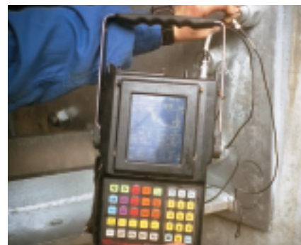
アンカーボルト長探査
