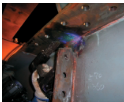
疲労亀裂調査 (磁粉探傷)
