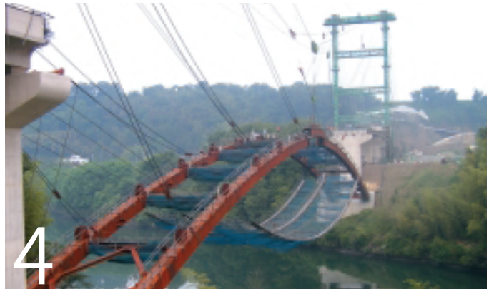
4 ケーブルエレクション斜吊架設
