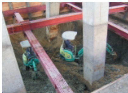
土留工内床掘
