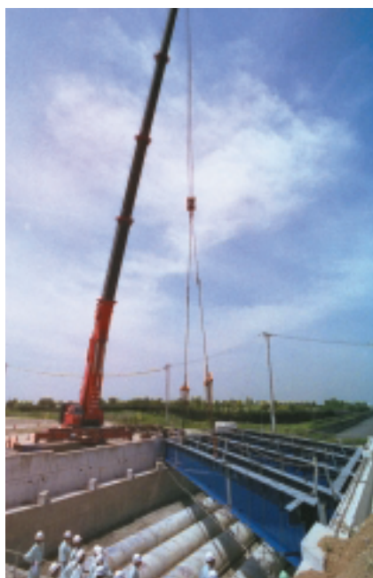
鋼橋製作架設
