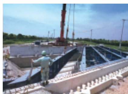
鋼橋製作架設
