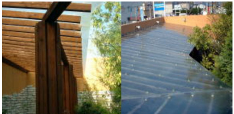
店舗テラス屋根材加工
