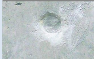
Pコン漏水部分施工後
