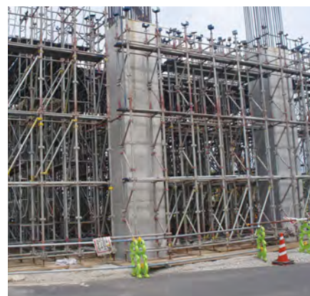
支保工足場材
