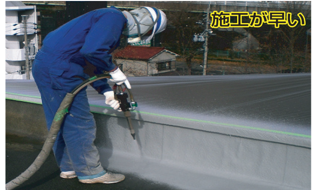
2. ジェットスプレー吹付作業
