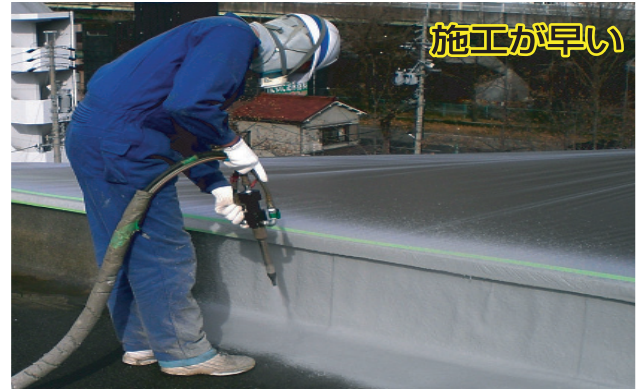
2. ジェットスプレー吹付作業
