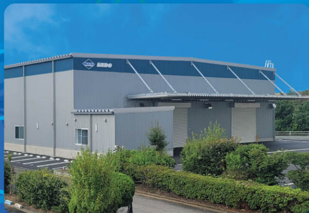
バネックス物流倉庫
