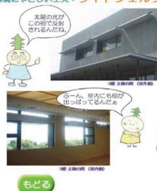
ライトシェルフとは光の棚、つまり光が反射しやすい棚を窓面に設け、射し込む太陽光を建物内部のより奥深くまでみちびくための工夫です。
