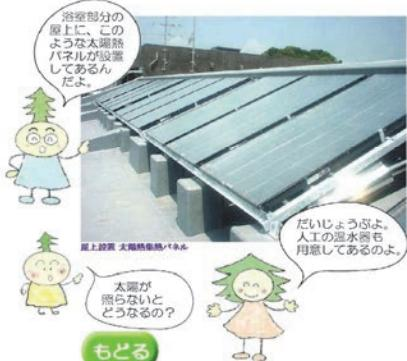
屋上に設置した温水パネルに太陽熱を集め、出来た温水をタンクに集め館内の給湯に利用しています。
