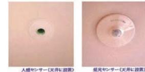
昼光センサーとは室内的明るさを感じ、暗くなると自動的に人工照明を点灯させるように信号を出します。自然の光が得られるときは、自然光を最大限に生かすための工夫です。
