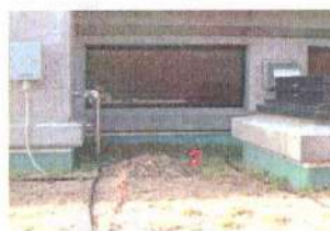
2 よく育っている。 外壁側の浴室排気の当たる場所 は特によく繁殖している。
