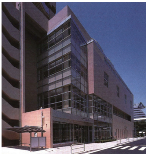
中スポーツセンター及び栄定住補足住宅
