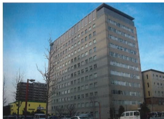
浜松地方合同庁舎
