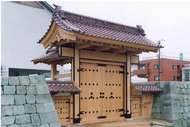
舎人門 復元工事
