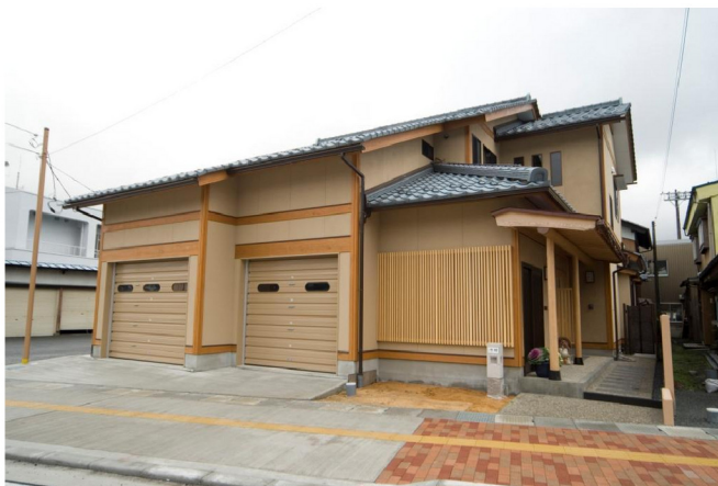
B邸 新築工事
