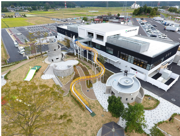
南条SA周辺地域振興施設新築工事（道の駅 南えちぜん山海里）
