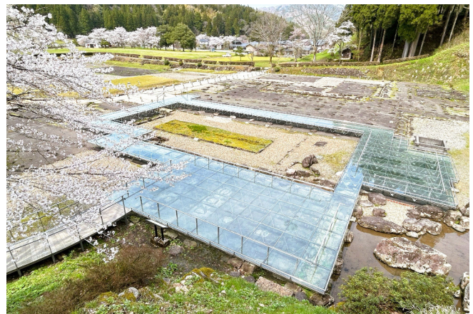
一乗谷朝倉氏庭園朝倉館跡再整備工事
