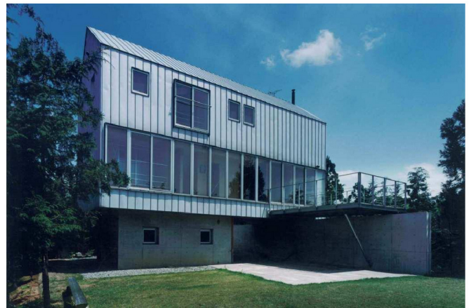
C邸 新築工事
