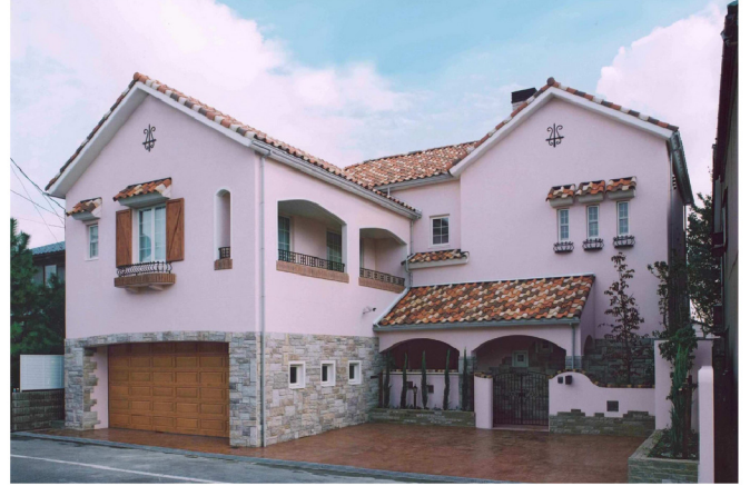
G邸 新築工事
