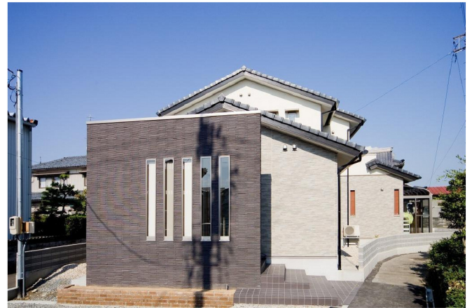
I邸 新築工事
