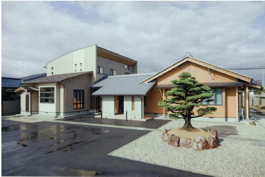
A邸 新築工事
