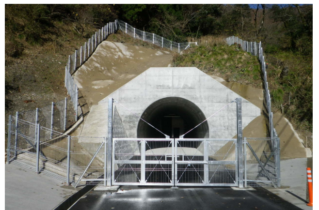
葉原トンネル工事
