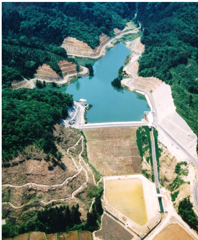
総ヶ谷ダム工事
