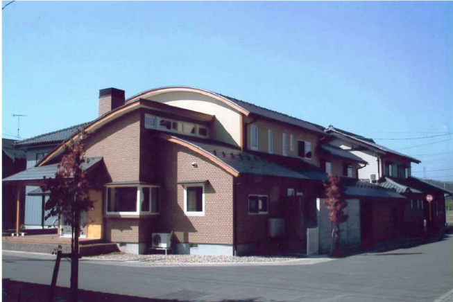
F邸 新築工事
