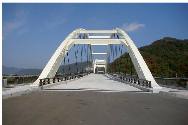
水鳥大橋建設工事
