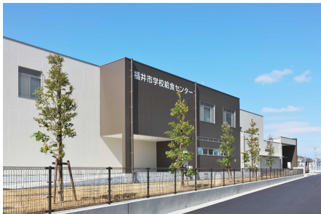
福井市学校給食センター新築工事
