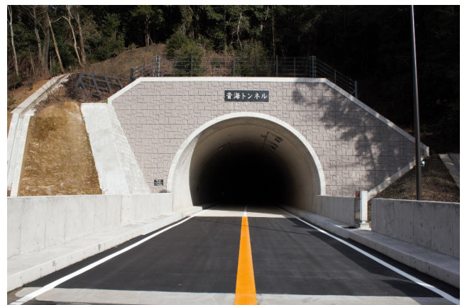
内浦トンネル工事 音海工区
