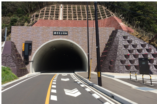
神子トンネル工事 小川工区
