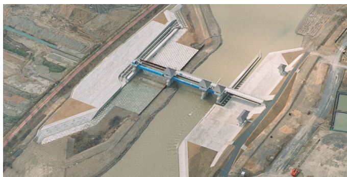
八乙女頭首工建設工事
