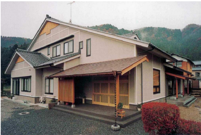
H邸 新築工事
