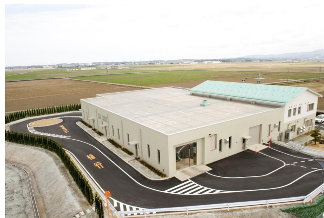
坂井汚泥センター
