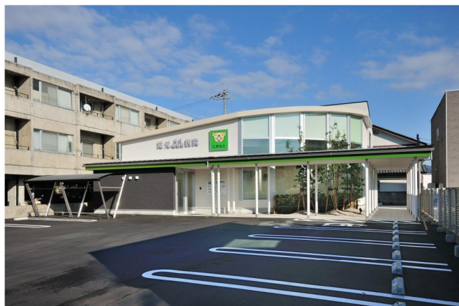
滝元耳鼻咽喉科医院新築工事
