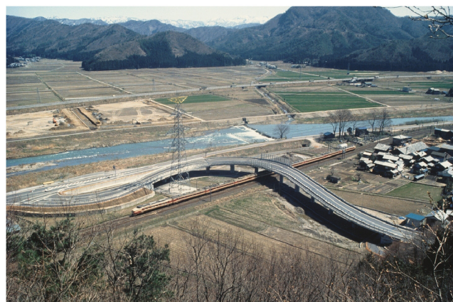
踏切除却事業
